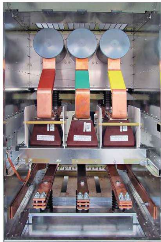
Кабельный отсек
