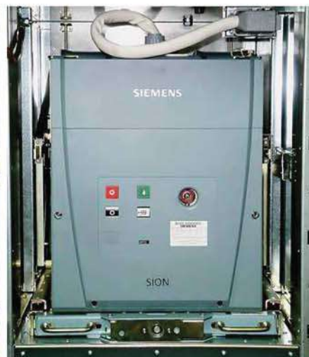
Отсек вакуумного выключателя с SION
